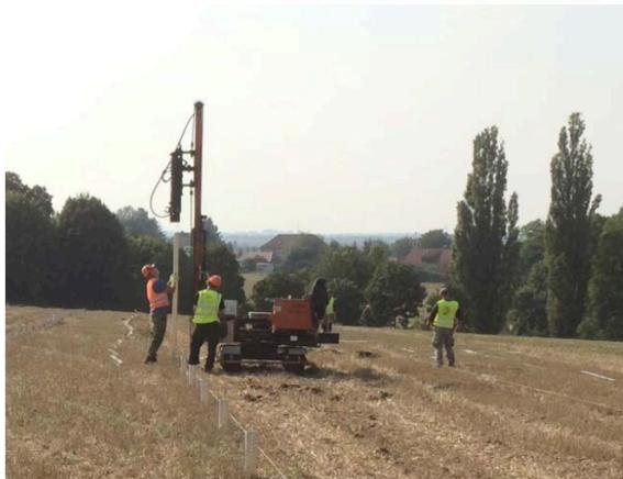
Abbildung 4-1: Beispieldarstellung Rammung
