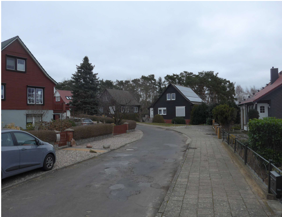
Eigenheimsiedlung „Schwaaner Straße“ aus den 1970/80 iger Jahren
