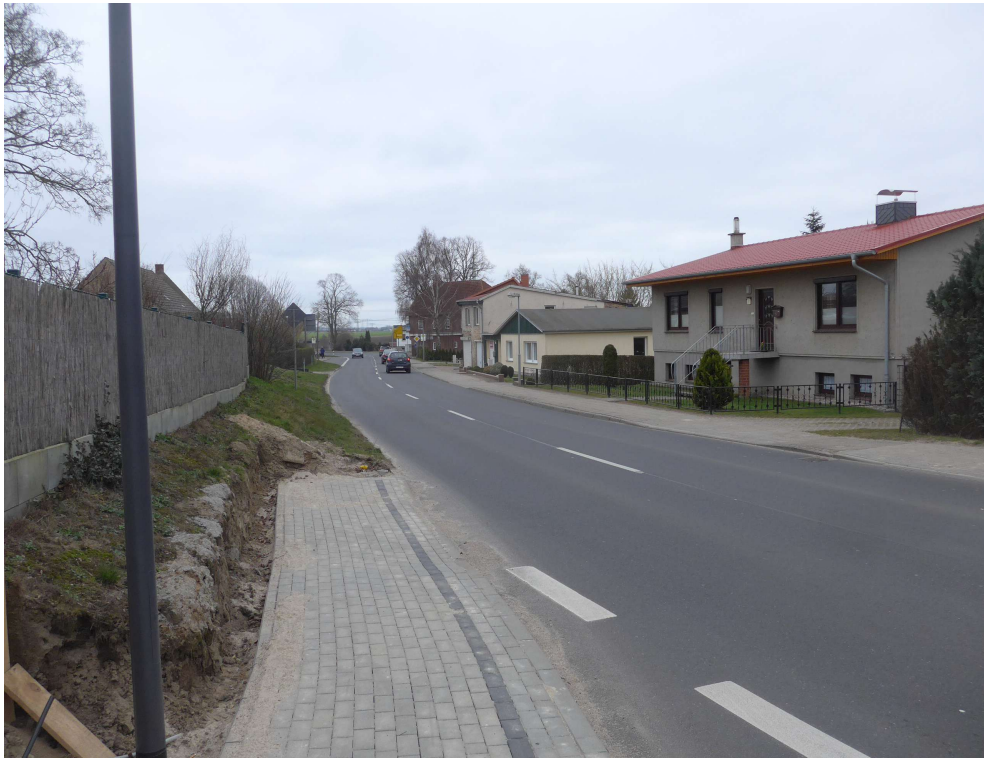
Strenz, Ortsdurchfahrt Landesstraße L 14
