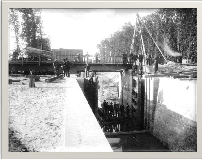
Foto Quelle: Heimatmuseum Güstrow Bau der Schleuse in Wolken
