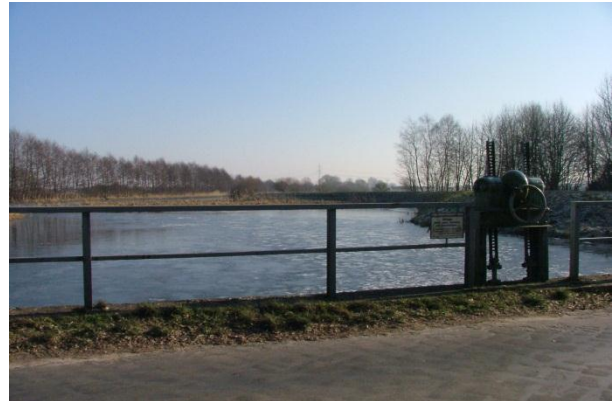
Das neue Wehr
