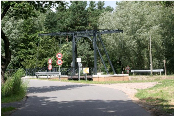
Die neue Zugbrücke
