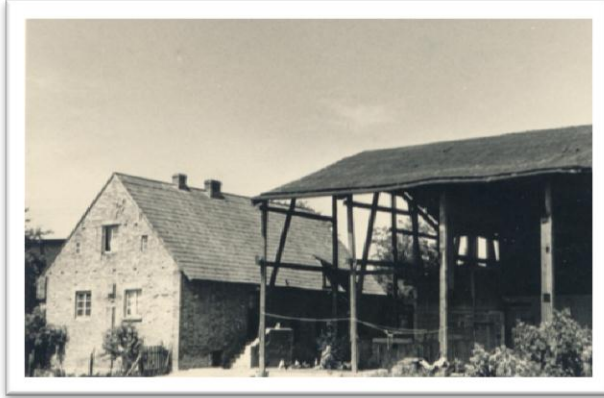
Überbleibsel der Scheune vom Resthof
