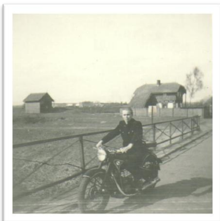
1969 wurde die 27m lange Brücke über den Kanal Instandgesetzt für 27.000,00 DDR Mark
